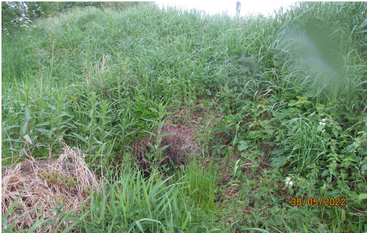
Фото 17. Трубопереезд на канале БМ-3-2 в верхнем течении
