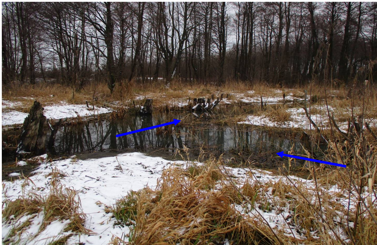
Фото 8. Место впадения канала БМ-7-2 в канал БМ-7 в районе пос. Орехово
