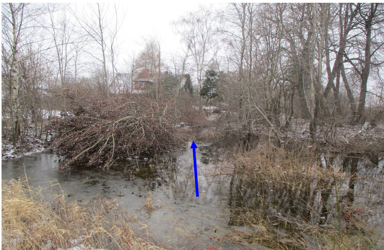
Фото 12. Вид русла канала БМ-7 в районе пос. Янтаровка в нижнем течении
