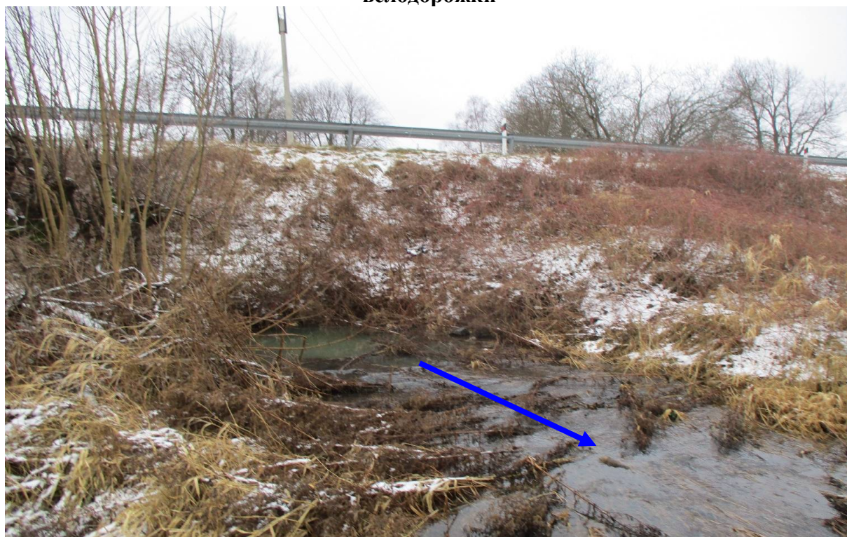
Фото 3. Трубопереезд в русле реки Зеленая(БМ-7-1) на дороге в пос.Молодогвардейское в нижнем течении
