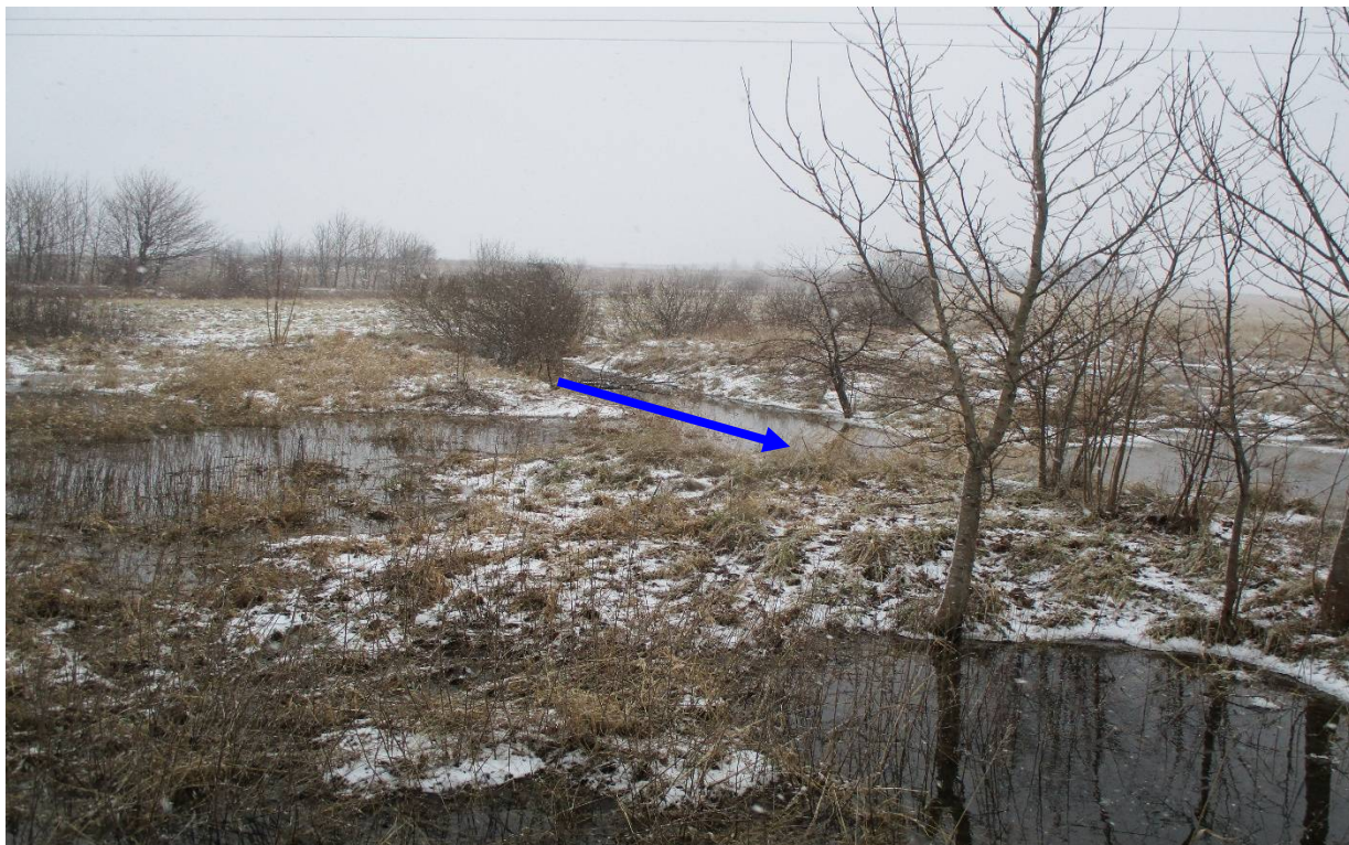
Фото 11. Вид русла канала БМ-7 в районе поселка Янтаровка в верхнем течении
