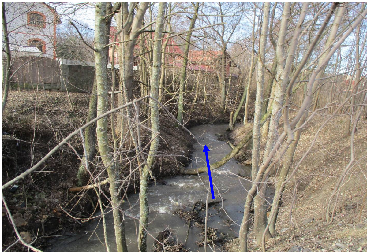
Фото 29. Вид русла канала БМ-1 в нижнем течении в районе пос.Покровское
