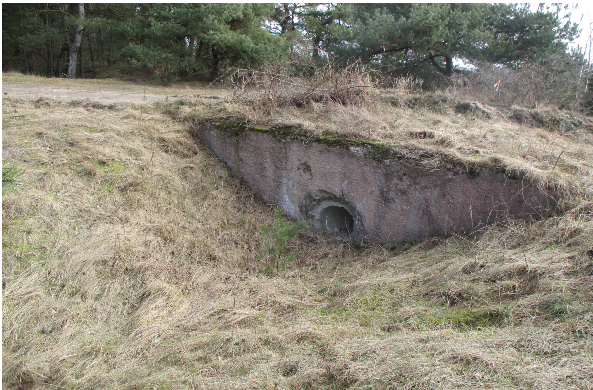
Фото 32. Трубопереезд на канале ПР-1-11-2 в нижнем бьефе
