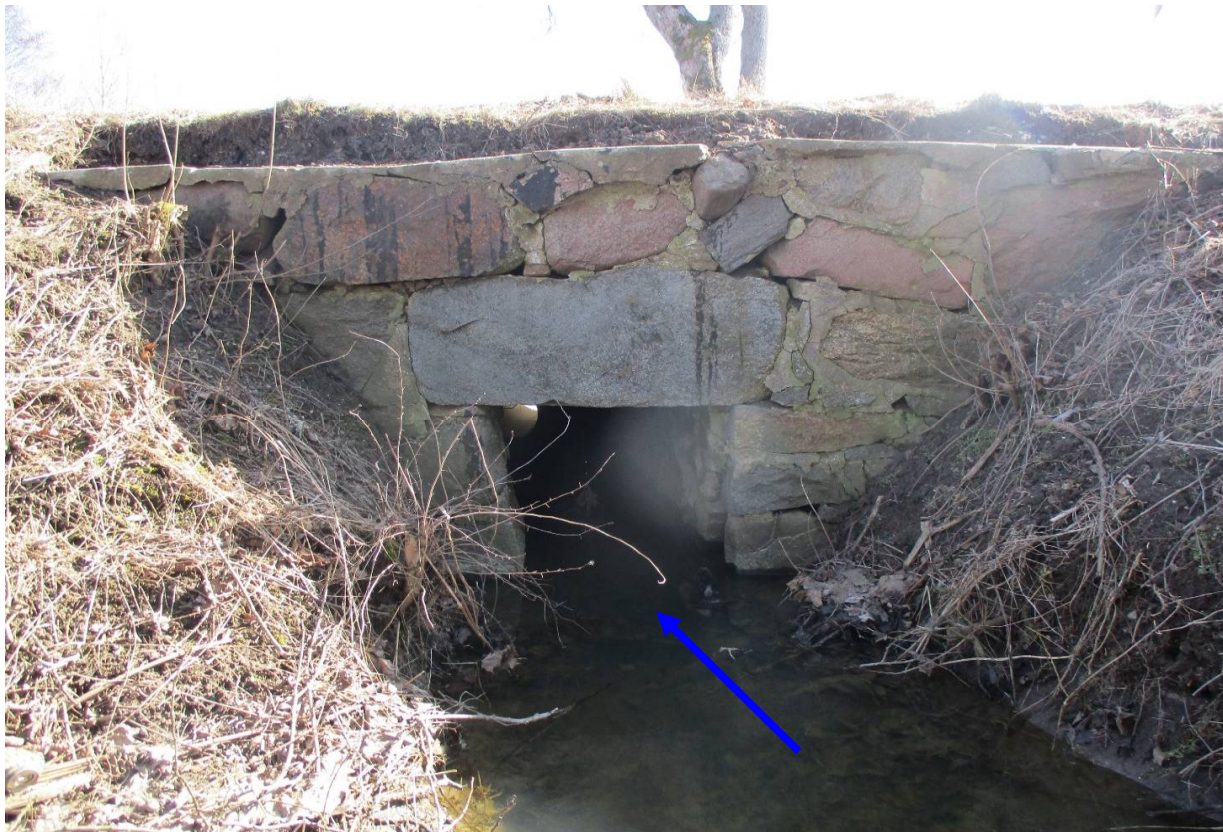
Фото 42. Вид сооружения на канале ПР-1-4 в верхнем бьефе
