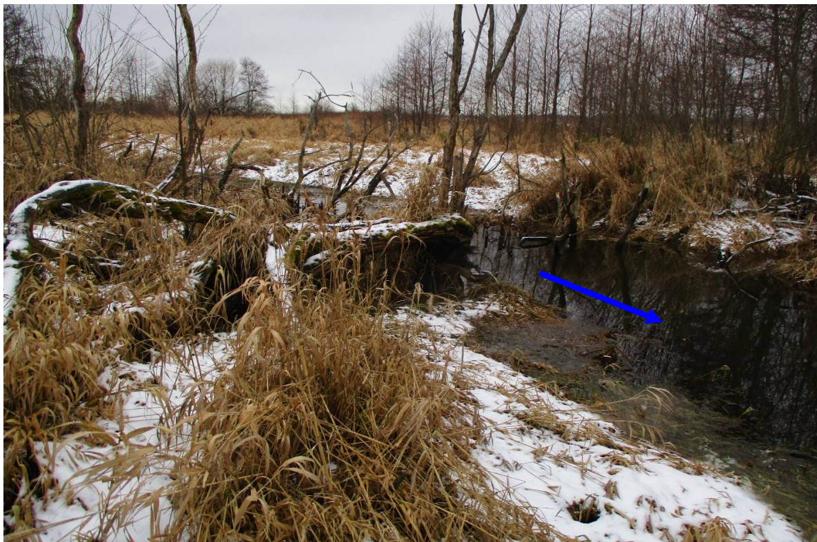
Фото 9. Вид русла канала БМ-7 выше впадения канала БМ-7-2
