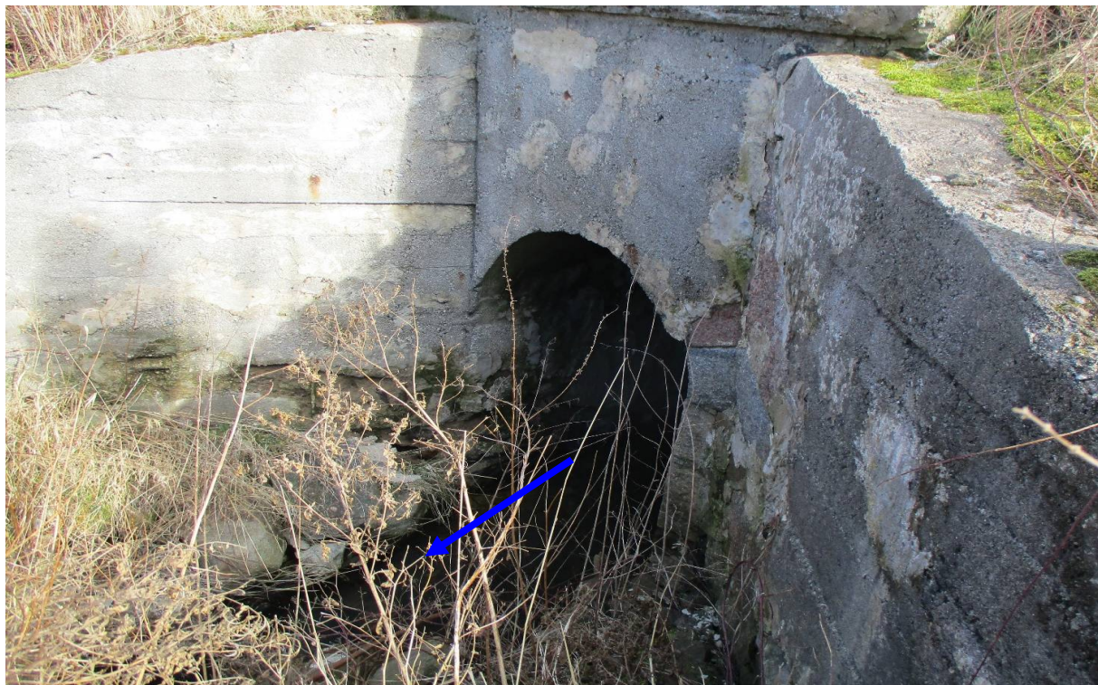
Фото 44. Трубопереезд на канале ПР-1-1а в нижнем бьефе
