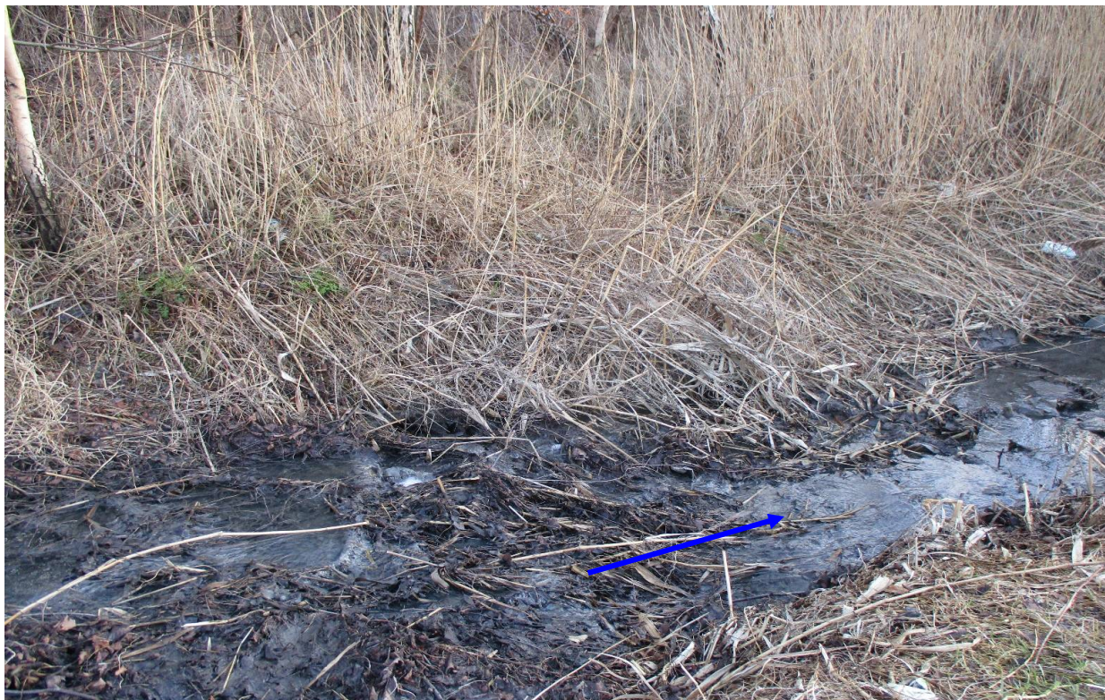
Фото 26. Вид русла канала БМ-3-1 в месте впадения в отработанный карьер на берегу Балтийского моря
