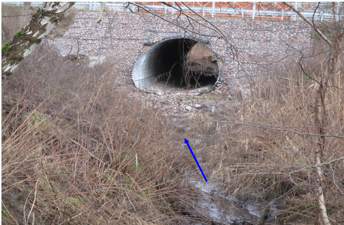
Фото 21. Труба на канале БМ-3-1 под улицей Советская верхний бьеф
