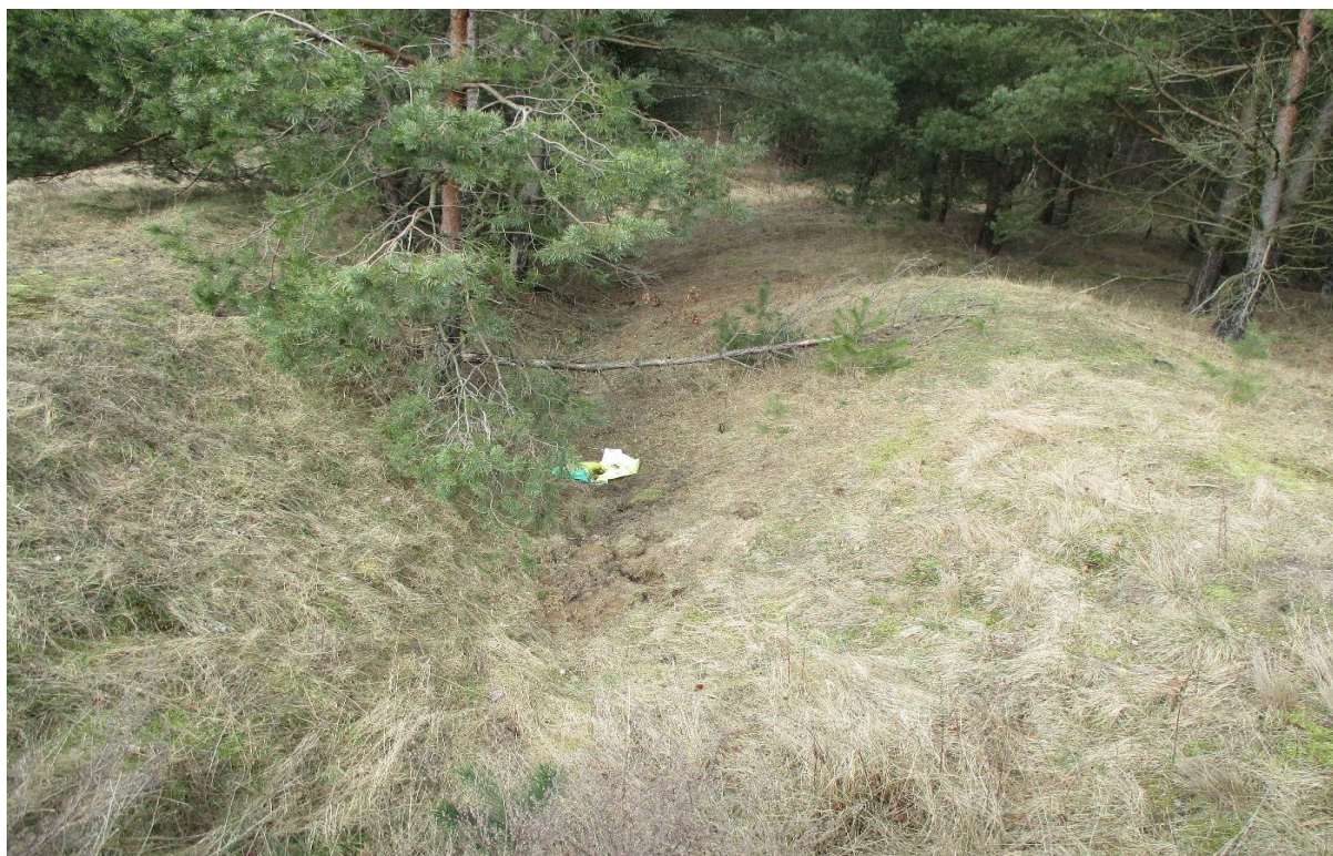
Фото 31. Вид русла канала ПР-1-11-2 в верхнем течении в створе пересечения с трассой проектируемой велосодорожкой
