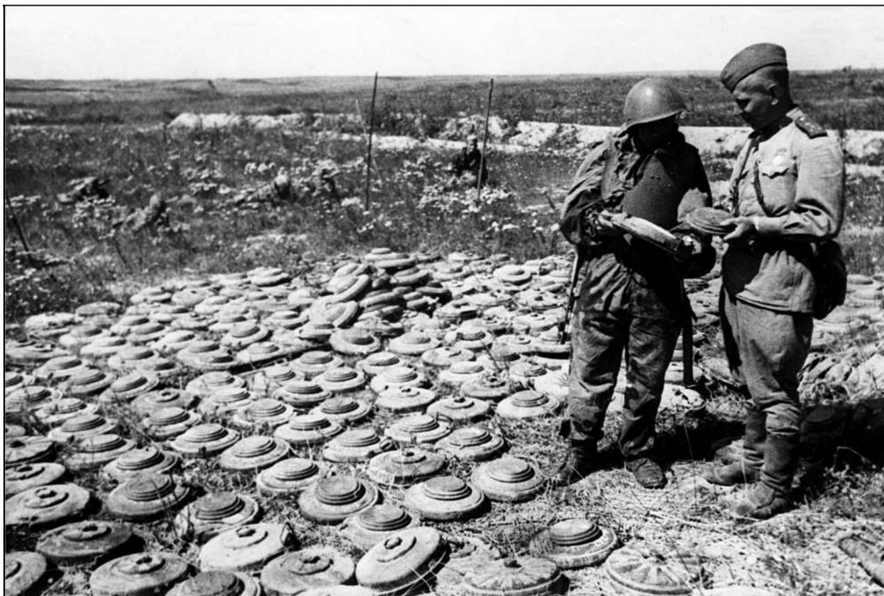
Рисунок 54 - Восточная Пруссия весной 45г. Снятое немецкое минное противотанковое поле. Мины еще с навинченными взрывателями. Такие изделия вполне могли прикрывать линии обороны в Пиллау на танкодоступных местах. (13)
